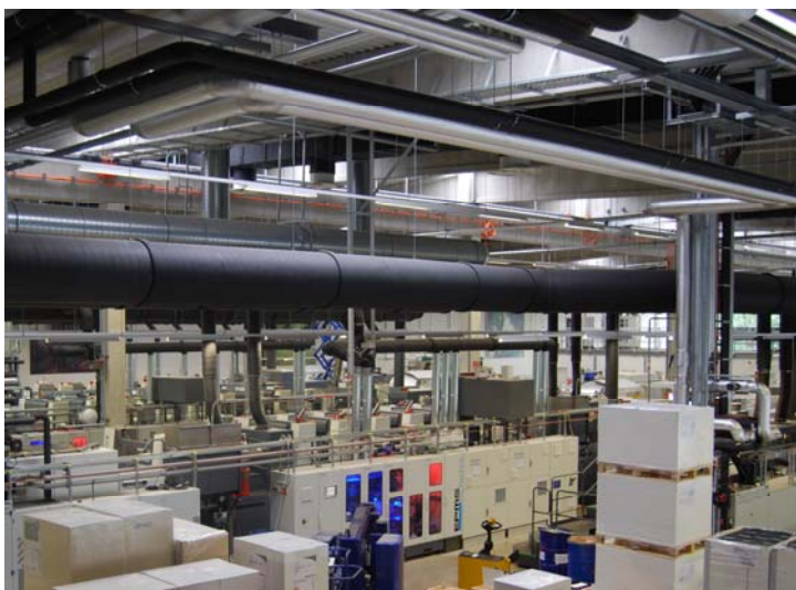
Bild 2: Die Trocknungsaggregate aller Druckmaschinen sind in das Wärmerückgewinnungssystem integriert
